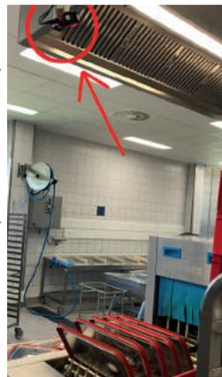
Scanvorrichtung zur Erfassung der QR-Codes auf GN-Behältern / -Deckeln an der Spülmaschine in Wilhelmsdorf.
