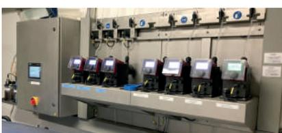
Zentrale Dosieranlage mit Membranpumpen von Dr. Weigert in Bochum
