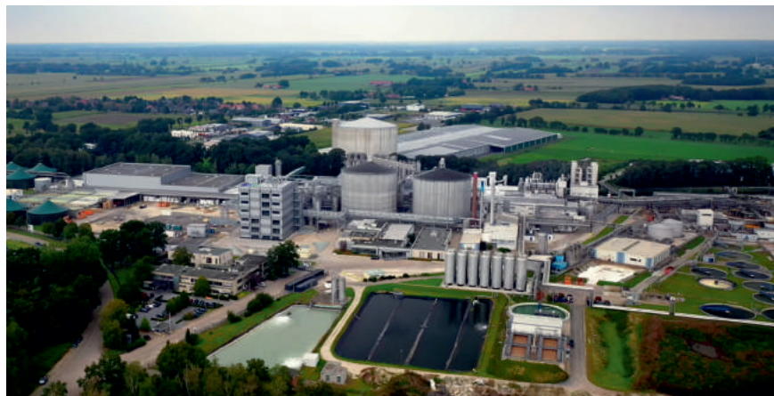
Abbildung 5: Ausblick auf das Werk in Emlichheim
