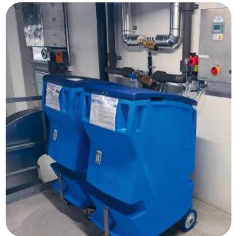
*Der Kunde profitiert nun von einer RDG-Redundanz durch zwei Maschinengruppen sowie einer automatischen Fassumschaltung – beides verbessert Sicherheit und Verfügbarkeit deutlich. Zudem wurde das dezentrale Desinfektionsmitteldosiergerät an die Dosieranlage angebunden, was Ergonomie und Arbeitssicherheit erheblich steigert.*
