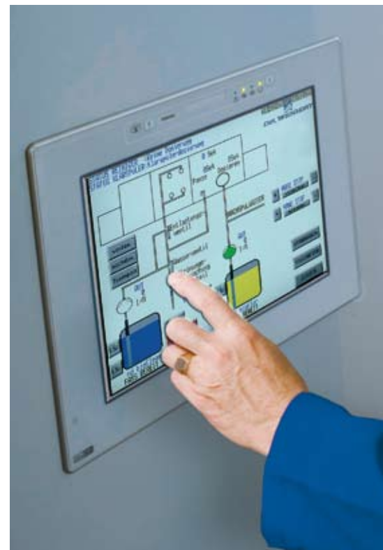
Herzstück der Dosierstation: SPS - Steuerung mit Touchpanel - Bedienung
