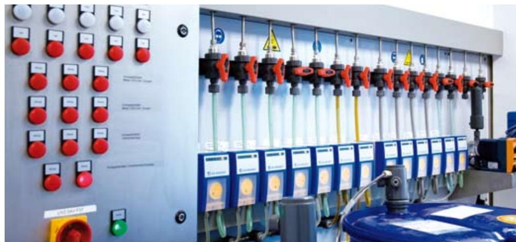
**Die zentrale Dosieranlage zur Versorgung von insgesamt 11 Einkammer-Reinigungs- und Desinfektionsautomaten von Miele**
