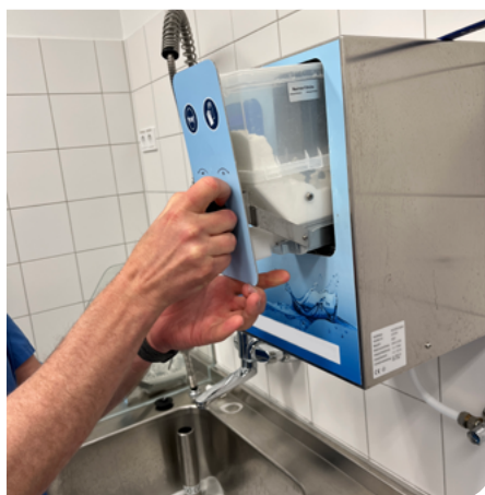
Entnahme des Pulvorratsbehälters
