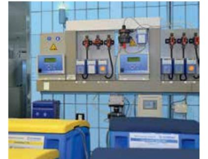
Dank der Dosierung der Prozesschemikalien aus weigomatic® Drumtainern entfällt die Auffangwanne
