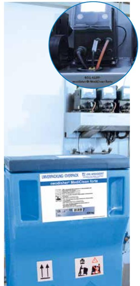
**Ausschnitt der zentralen Dosieranlage, in welcher u. a. die Dosierung des mildalkalischen enzymatischen Universalreinigers neodisher® MediClean forte reguliert wird. Die Lagerung und der Transport der Fässer erfolgt in sicheren und komfortablen weigomatic® Drumtainern.**
