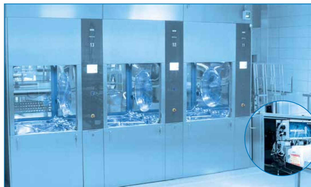
Im Unterschrank neben den RDG findet das kompakte Dosiersystem weigomatic® system ALPHA mit den Prozesschemikalien auf separat ausziehbaren Schubladen Platz. Ein System kann bis zu vier RDG versorgen. Vortagebehälter stellen die kontinuierliche Zudosierung ohne Leerlauf sicher.
