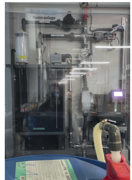
Dosieranlage für Peressigsäure-Produkte mit besonderen Sicherheitsvorrichtungen
