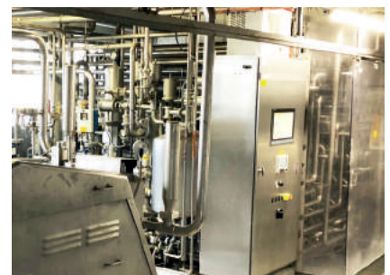
Eine besondere Herausforderung an die Reinigung: die UHT-Anlage (mit Steuereinheit) für die thermische Behandlung der Produkte
