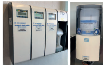
Machen einen zentralen Dosierraum verzichtbar: Zentrale Steuereinheiten des weigomatic® compact SMART und Klarspülerereinheit re.: Ausspülerereinheit mit dem EU Ecolabel Produkt neodisher® compact 180
